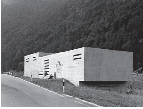
Unterwerk Vorderprättigau, Seewis (1995)
